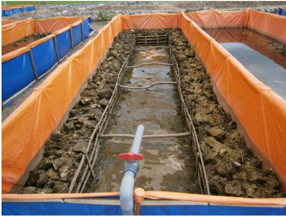
(ก) การเตรียมแ่งไม้ไผ่และดินภายในบ่อ
